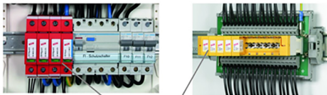
شکل ۲۱.۴ نمونه محافظه ولتاژهای گذرا در پیل PLC
