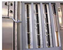
شکل ۳۷.۴ داکت عبوری در پیل PLC
