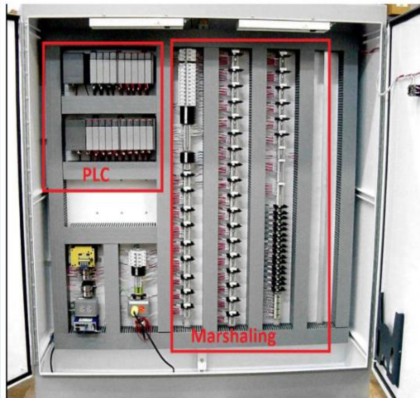
مارشالینگ در پنل PLC
